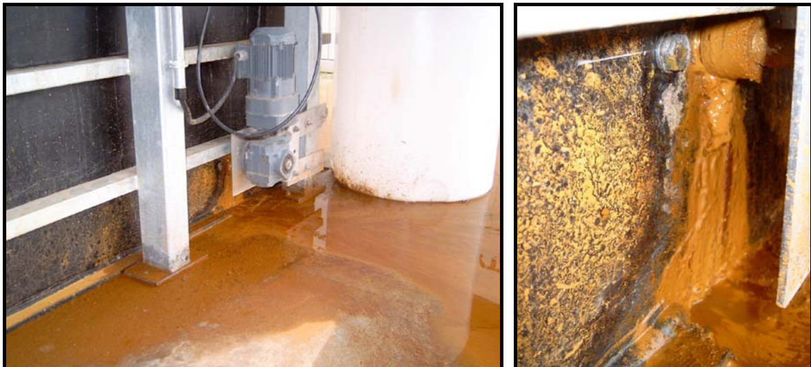
Abbildung 57: Erneutes Auftreten, diesmal massiver Undichtigkeiten an der Antriebswelle des Kettenräumers Mitte Juli 2007
