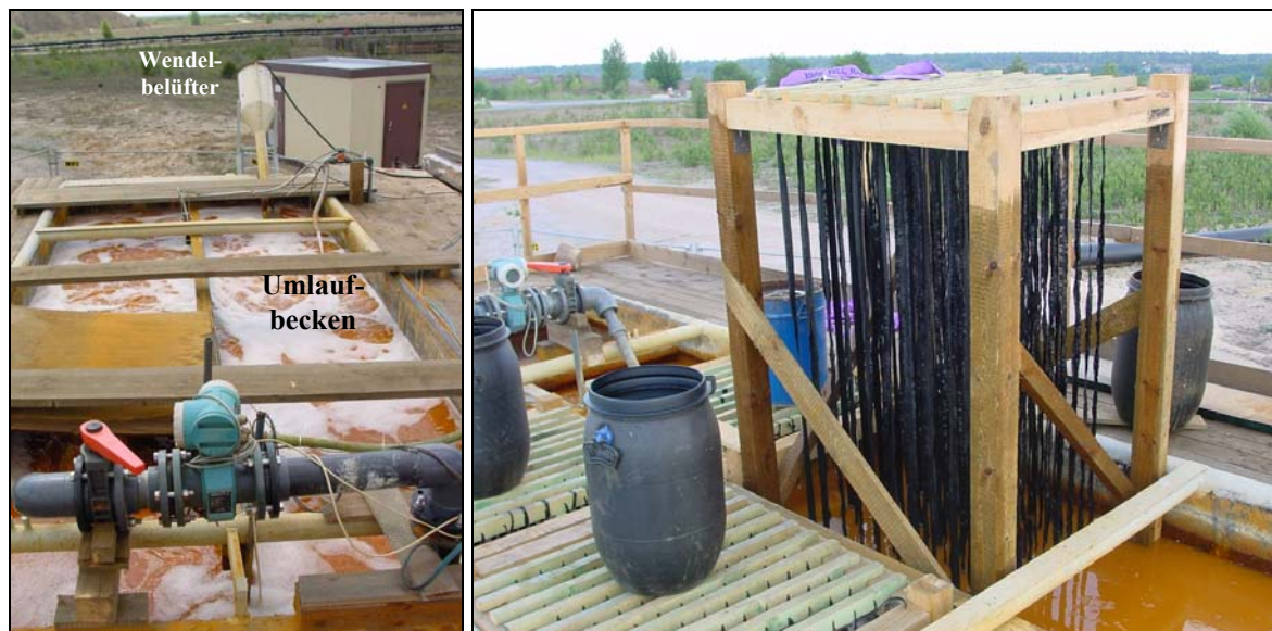
Abbildung 4: Links: Oxidationsbecken mit Wendelbelüfter und Umwälzpumpe. Rechts: Einbau des Trägermaterials
