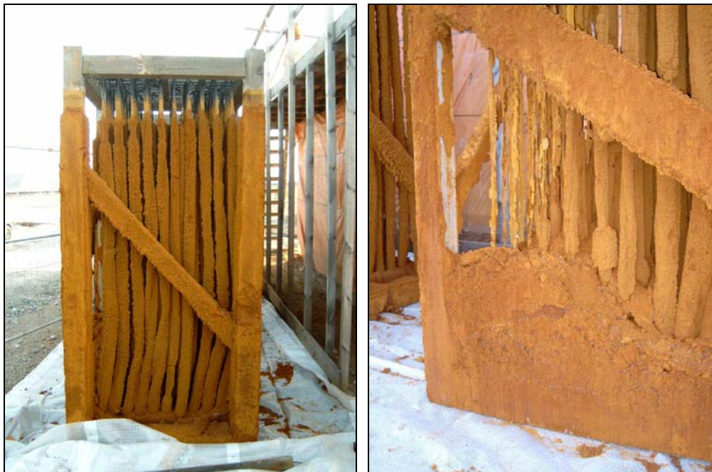
Abbildung 21: Mit EHS bewachsener Aufwuchsträger des Oxidationsbeckens
