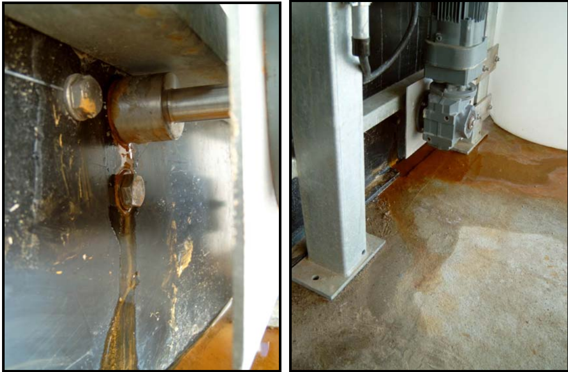
Abbildung 56: Erste Undichtigkeiten an der Antriebswelle des Kettenräumers am 14.03.2007
